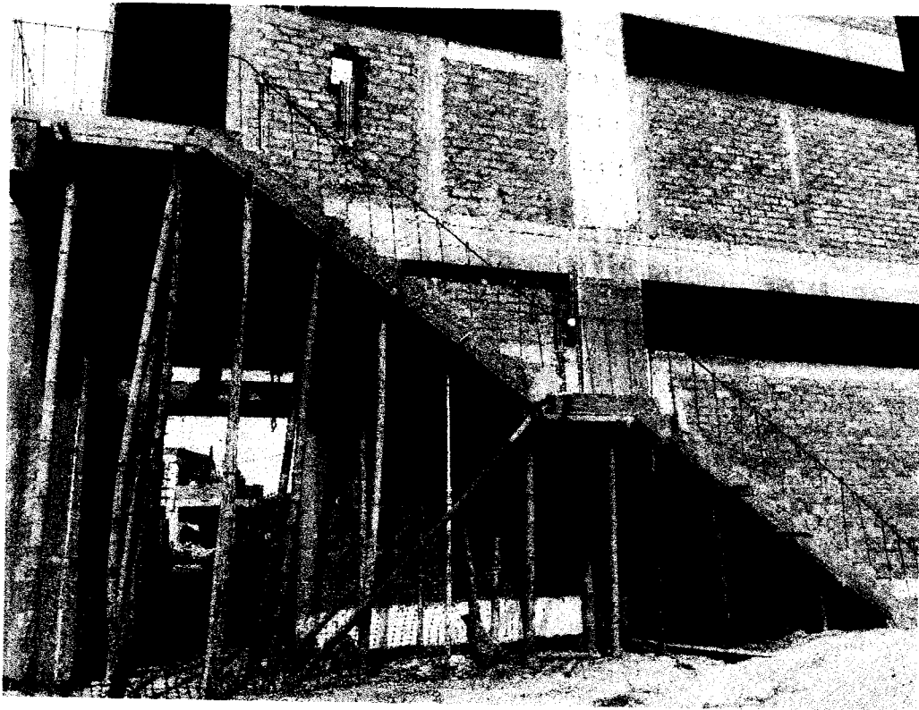
FOTO N° 03: Construcción de escalera exterior de área de frío.
