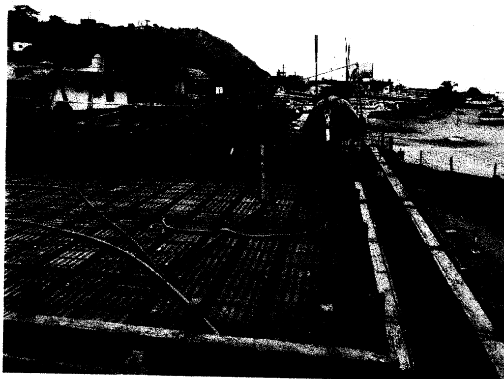
Foto N° 07: Encofrado de losa aligerada y vigas del área faltante de tareas previas.
